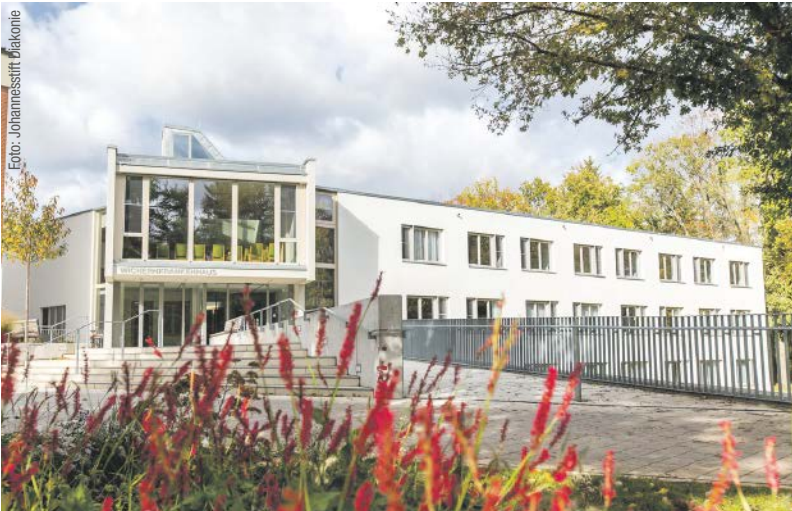
Rechts der moderne Neubau des Wichernkrankenhauses in Berlin-Spandau, links der „neue Altbau“, wie er intern genannt wird. Von außen unverändert, von innen kernsaniert.
