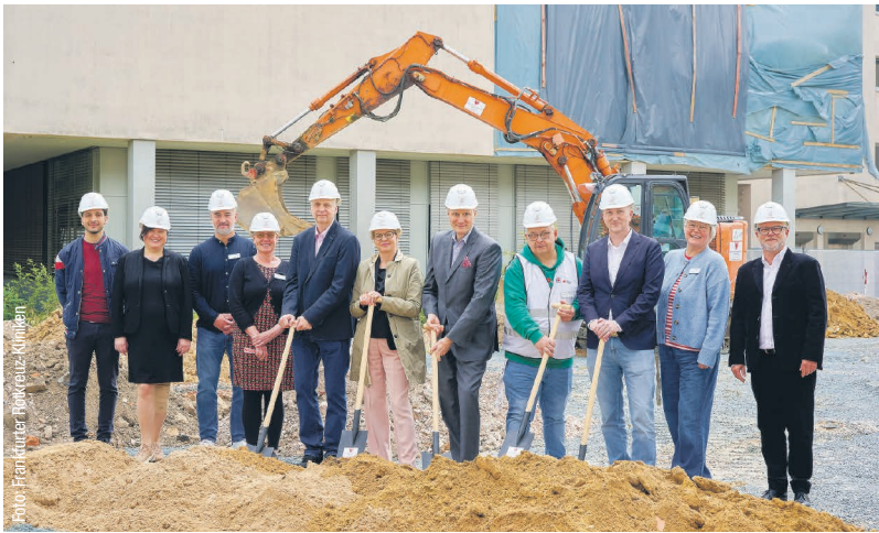
Offizieller Spatenstich für den neuen OP-Anbau der Frankfurter Rotkreuz-Kliniken e.V.
