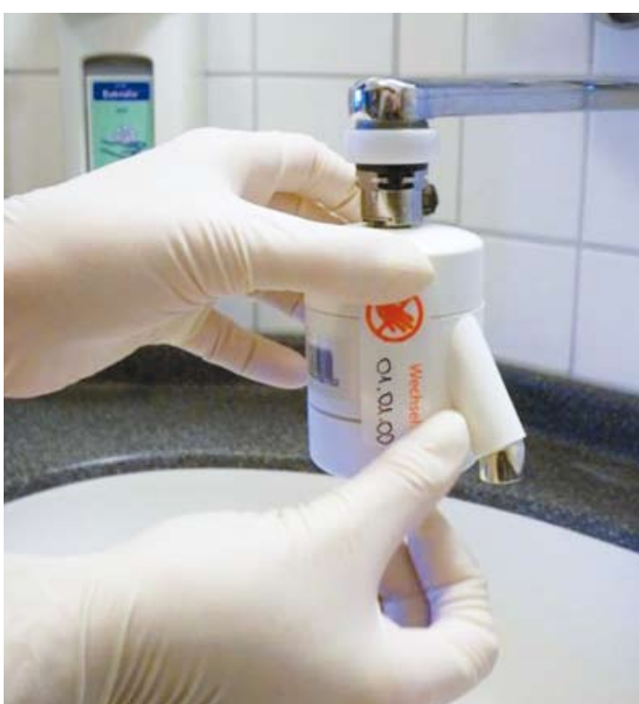
Installation eines Wassersterilfilters in der Praxis
