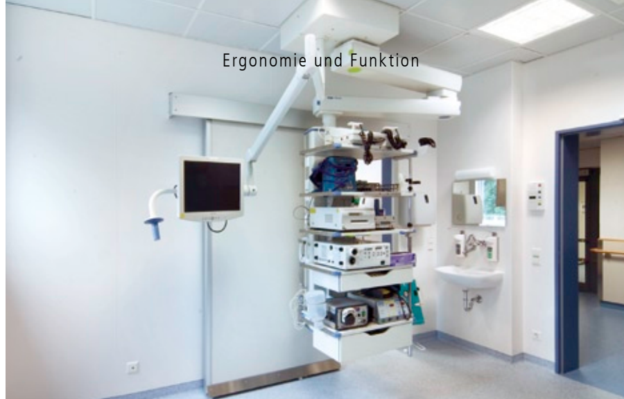
140 m 2 hygienische Wandverkleidungen wurden in drei Räumen des OP-Zentrums installiert.
