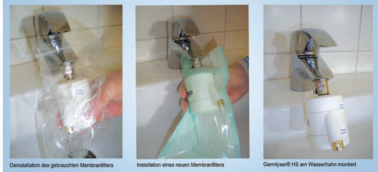
Deinstallation des gebrauchten Membranfilters
