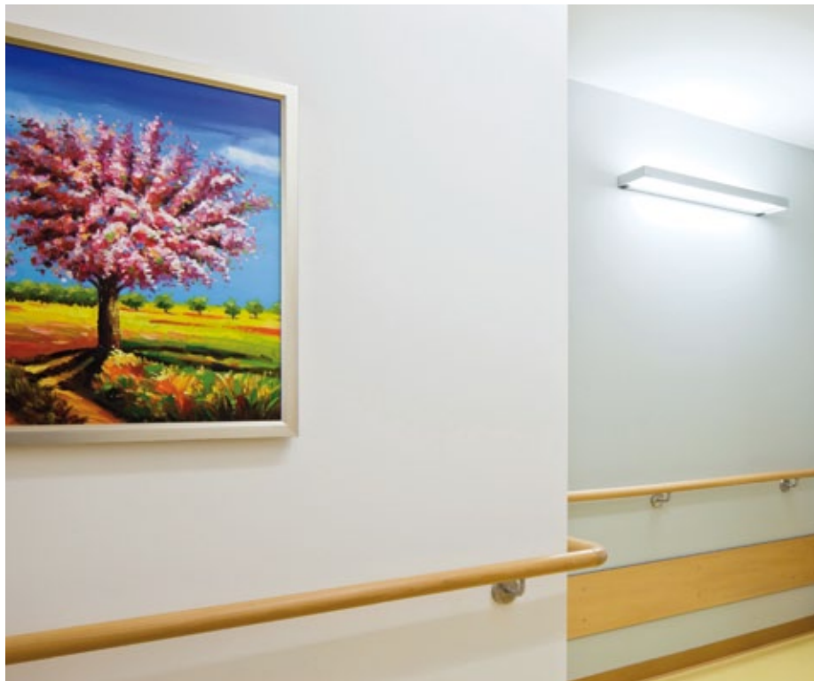
In Fluren ist die Ausleuchtung auf dem Fußboden und die Beleuchtungsstärke in Augenhöhe wichtig.
