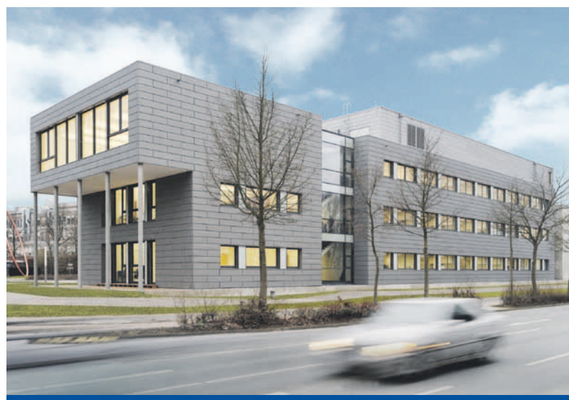
Laborgebäude MEET-Arkaden an der Universität Münster, Bergstermann + Dutczak Architekten
