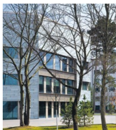
Das neue Laborgebäude des Max-Delbrück-Centrums für Molekulare Medizin (MDC) auf dem Campus Berlin-Buch. Foto/Copyright: Horst Krüger, Berlin
