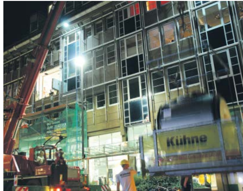
Der spektakuläre Einbau des neuen MRT über die geöffnete Fassade der ATOS Klinik Heidelberg
