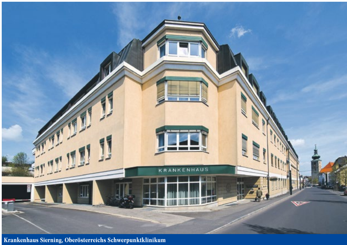
Krankenhaus Siering, Oberösterreichs Schwerpunktzentrum
