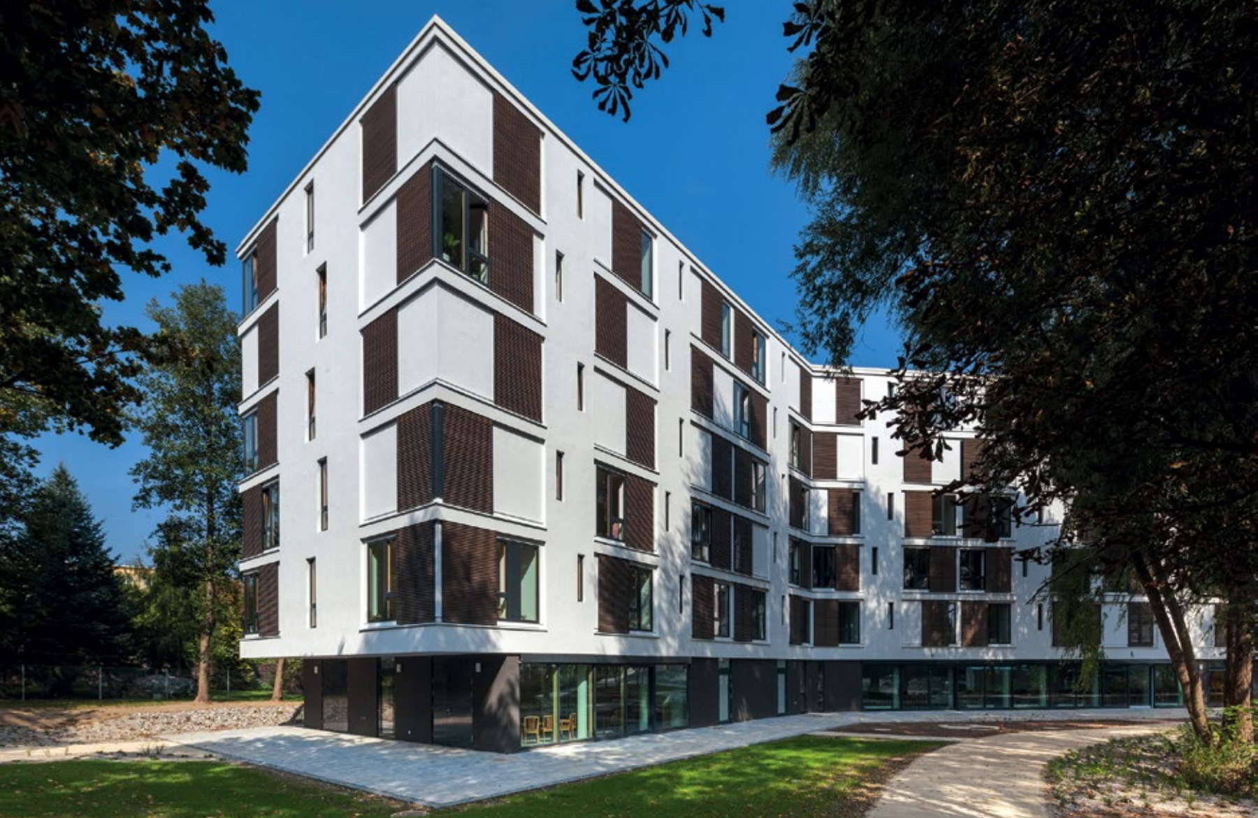
Das Seniorenzentrum „Regine Hildebrandt“ wurde im Herbst 2014 fertig. Bei der Gestaltung des Gartens arbeiten die Architekten von Gewers Pudewill mit dem Landschaftsarchitekturbüro Hutterreimann zusammen.
