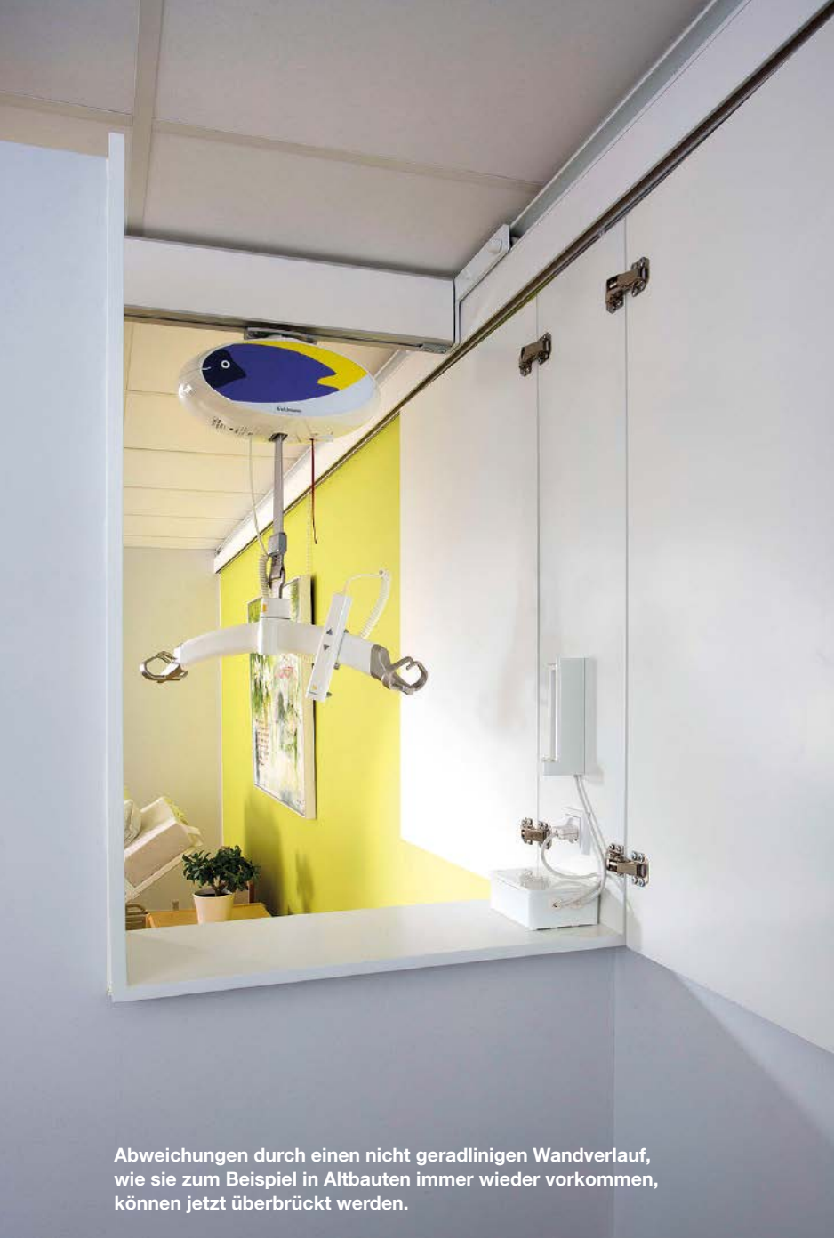
Für Decken- oder Wandmontage: Deckenliftsystem von Guldmann.
