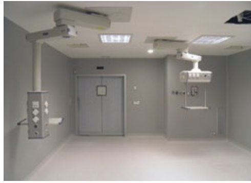
Der Operationssaal eines Krankenhauses in Madrid, Spanien, nutzt Lexan Cliniwall-Platten für die Wandverkleidungen.
