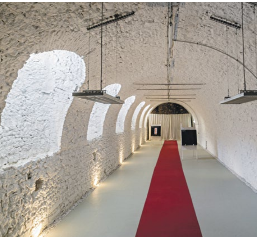
Elektroplanung im Denkmalschutz: Bogenschießanlage im Gewölbekeller des Schlosses
