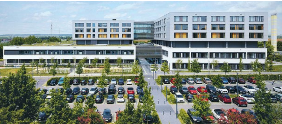
Klinikum am Plattenwald: Blick auf den Haupteingang
