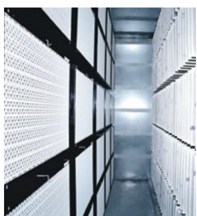
2-stufiges Filtersystem mit Viledon Taschenfiltern als Vorfilter und Viledon MaxiPleat Kassettenfiltern in der Endfilterstufe
