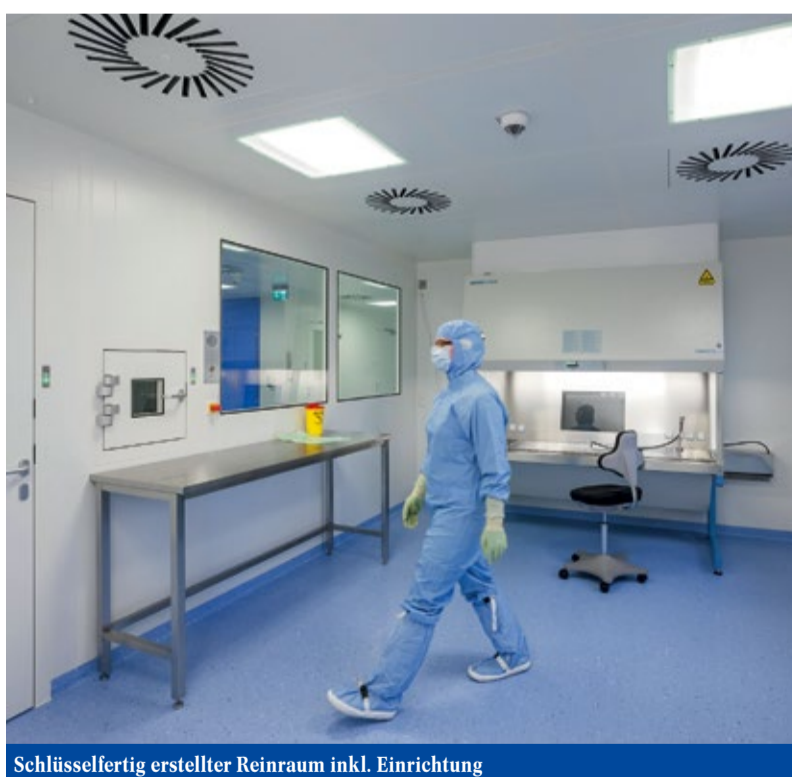
Schlüsselfertig erstellter Reinraum inkl. Einrichtung
