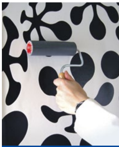
Nachdem die Tapetenbahn lotrecht unter Berücksichtigung der mitgelieferten Verarbeitungszugabe ausgerichtet ist, muss die Tapetenbahn luftblasenfrei angerollt werden.
