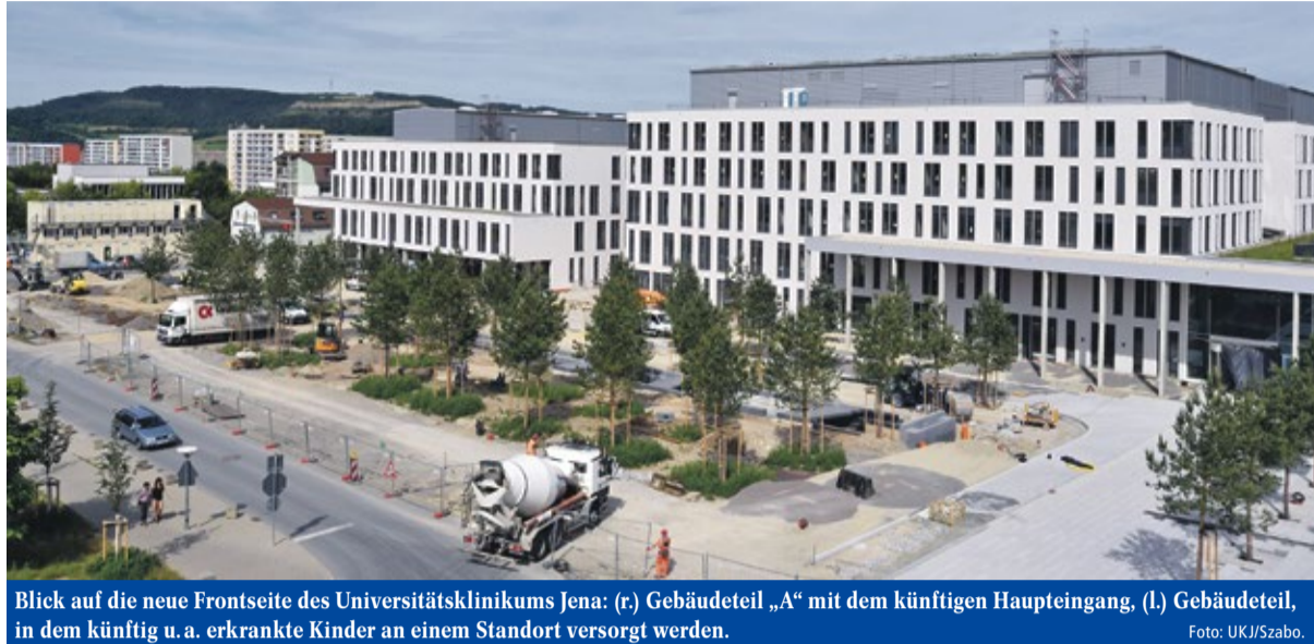
Blick auf die neue Frontseite des Universitätsklinikums Jena: (r.) Gebäudeteil „A“ mit dem künftigen Haupteingang, (l.) Gebäudeteil, in dem künftig u. a. erkrankte Kinder an einem Standort versorgt werden. Foto: UKJ/Szabo.
