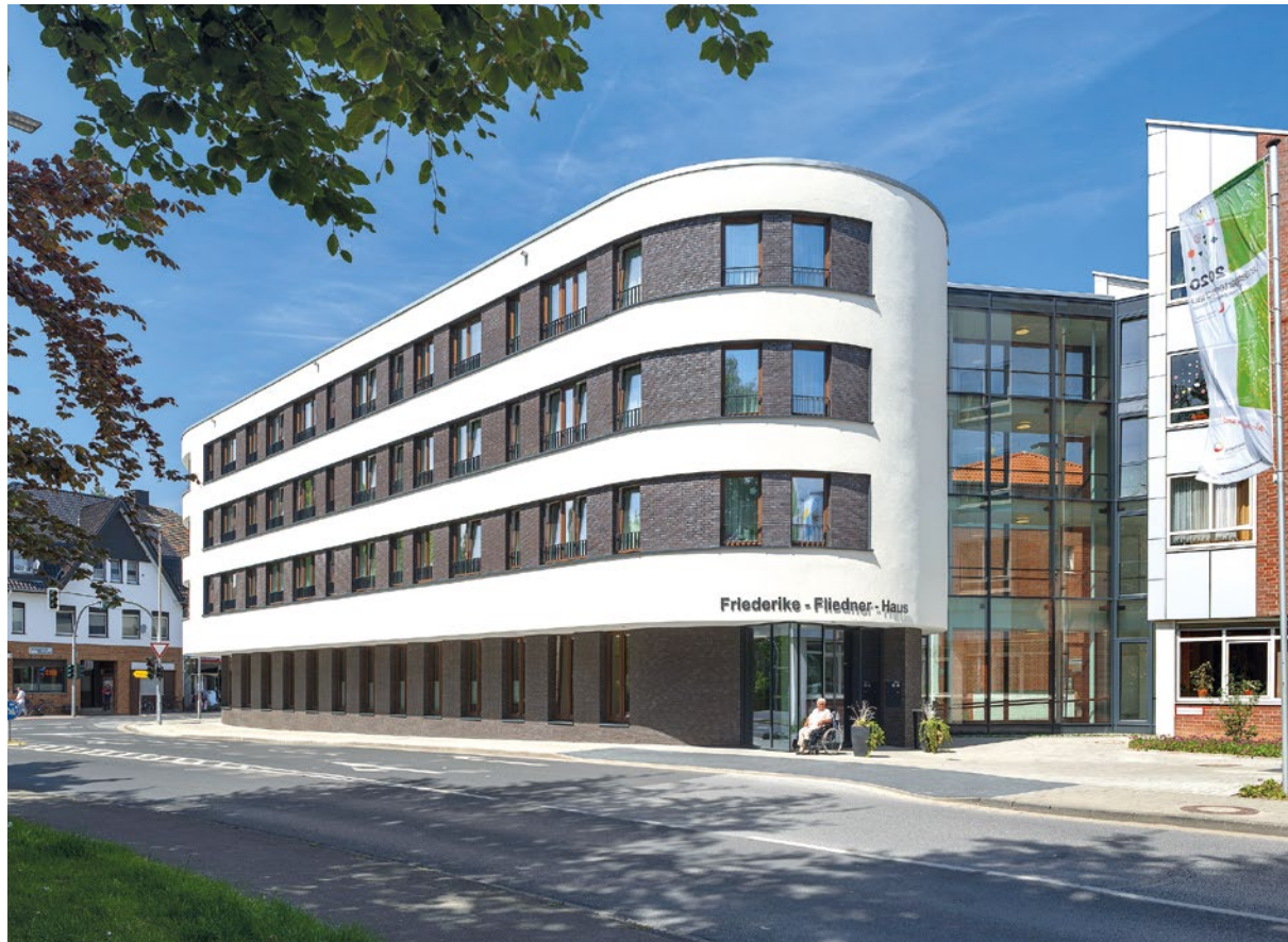
Eröffnet im März 2016: Der viergeschossige Neubau ist mit einem gläsernen Gang mit dem Bestandsbau verbunden.
