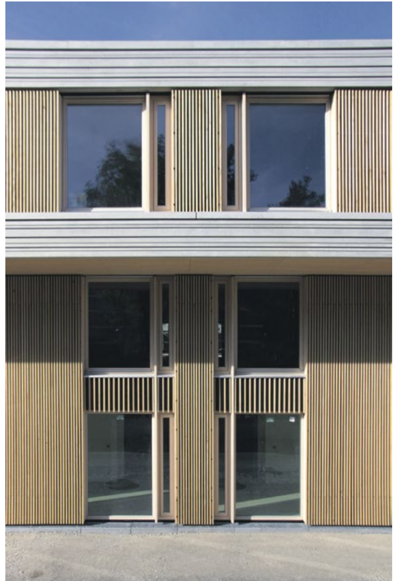
Die Fassade besteht aus unbehandelter Weißtanne, eine Referenz ans regionale Bauen, vor allem im benachbarten Vorarlberg.
