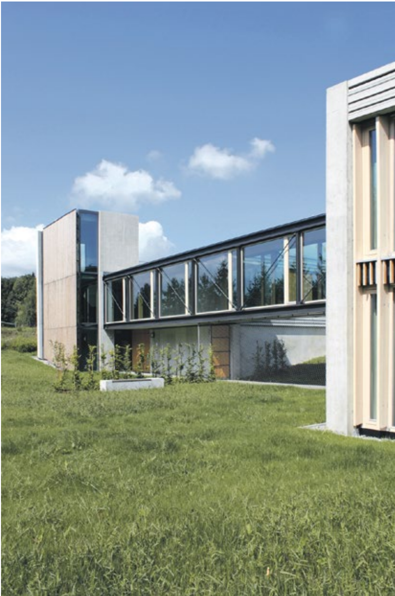
Die außenliegenden Markisen und der Einsatz von Sonnenschutzglas sorgen für Sonnenschutz.
