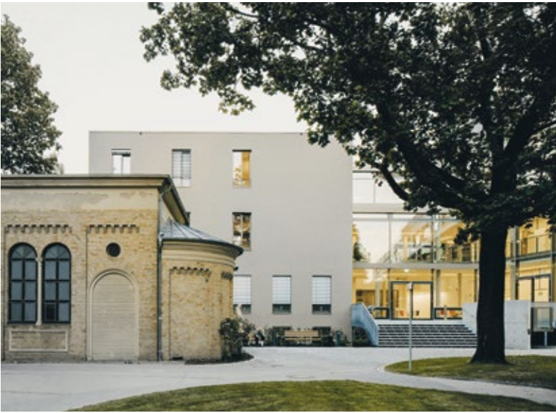
Neubau berücksichtigt denkmalpflegerische Anforderungen bei Fassadengestaltung, Materialität und Farbigkeit alternativ: Zugang Erweiterungsbau (Neubau) vom Gartenhof, Bestandsgebäude (heller Klinker) im Vordergrund
