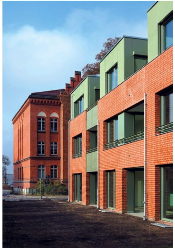
Barrierefreie Wohnungen auf einem ehemaligen Kasernengelände.
