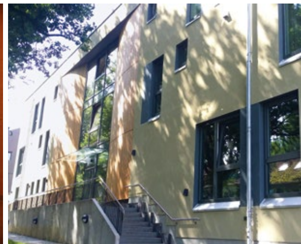
In Hamburg-Sülldorf entstand eine Wohngruppenhaus für Menschen mit und ohne Behinderungen – errichtet vom Förderverein Franziskus gemeinsam mit der Benno-und-Inge-Behrens-Stiftung.
