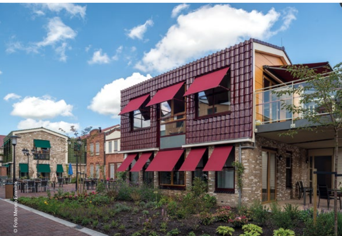
Eine große Herausforderung für das Bauunternehmen stellte die Verwendung von sieben verschiedenen Ziegeln dar.
