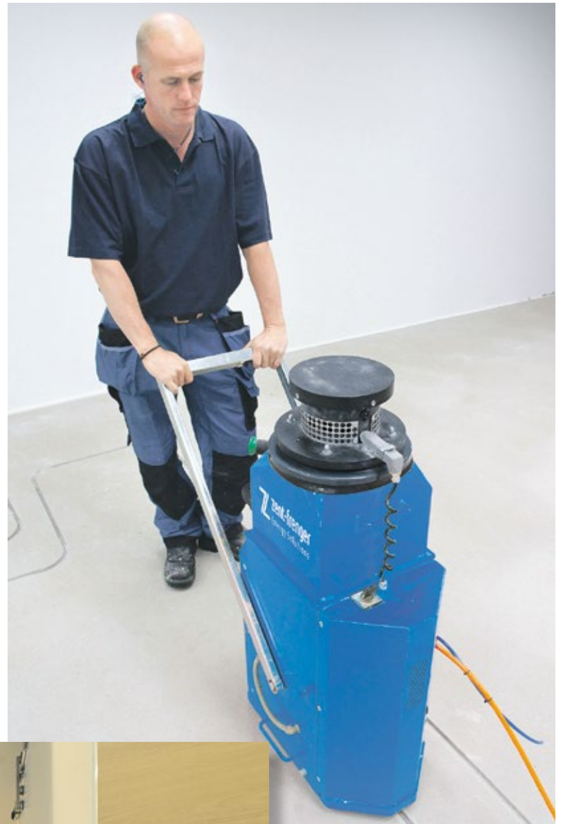
Eine Spezialmaschine mit eingebautem Industriestaubsauger fräst die Kanäle für die Fußbodenheizung schnell und staubfrei in den vorhandenen Estrich.
