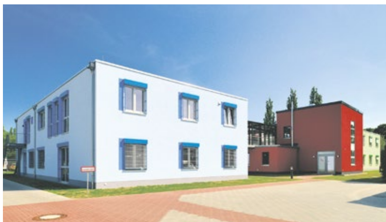
Ursprünglich waren die Gebäude von den beauftragten Architekten Hackel & Preß als Massivbauten geplant. Doch nach Besichtigung eines Referenzgebäudes in Alho Modulbauweise wurde beschlossen, die Gebäude in Tangermünde als Modulbauten ausschreiben zu lassen. Foto: Alho Holding GmbH
