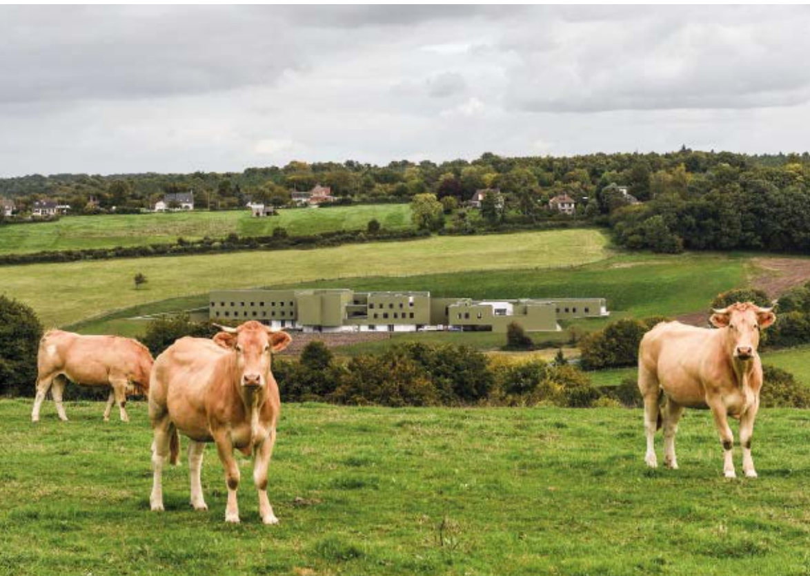
„Stealth“-Architektur: Das Altenpflegeheim in Orbec in der Normandie in Frankreich. Foto: David Romero-Uzeda.
