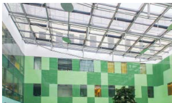
Uniklinik in Szeged an der serbisch-rumänischen Grenze Ungarns: Haupthalle als glasüberdeckter Hof mit bedruckt-/gefärbten Glasverkleidungen.
