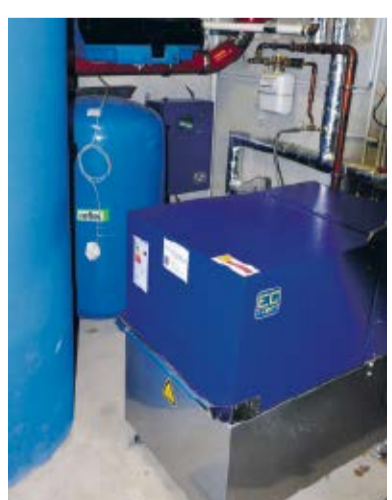
Kraftwärmekoppler XRG 6 mit Komponenten in der Kölner Innenstadt. Der japanische Einliter-Dreizylinder-Motor zeichnet sich durch eine hohe Laufruhe von 49 db(A) aus und gehört zu den leisesten Geräten auf dem Markt.
