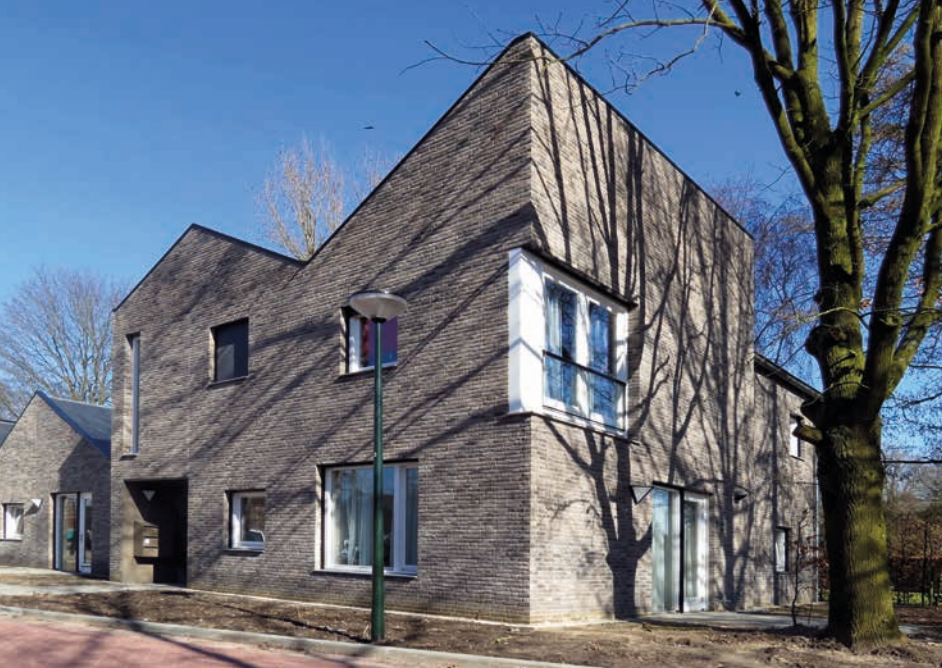
Wohnen für geistig behinderten Menschen – ein Projekt des Büros Molenaar & Bol & VanDillen architecten, realisiert in Haaren.
