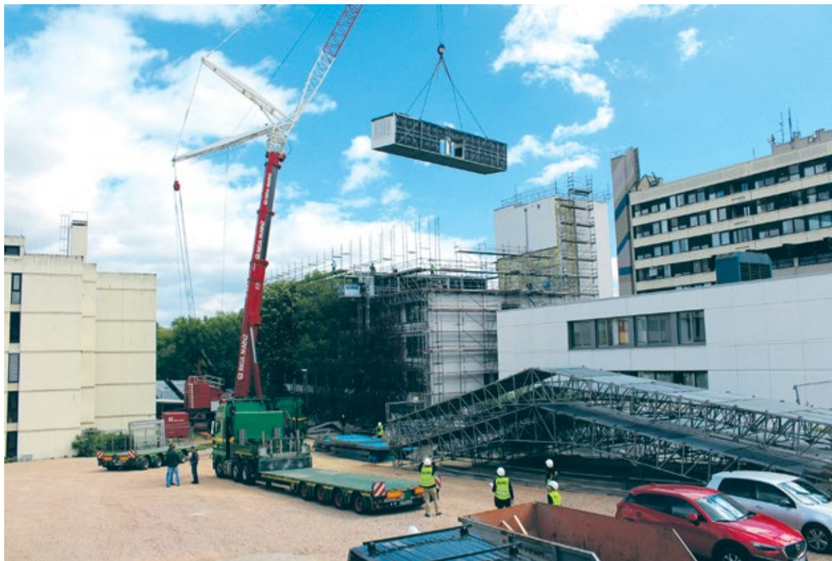
„Fliegende Bauten“: Einer Modulbauweise zuzuschauen, ist immer wieder ein Erlebnis!
