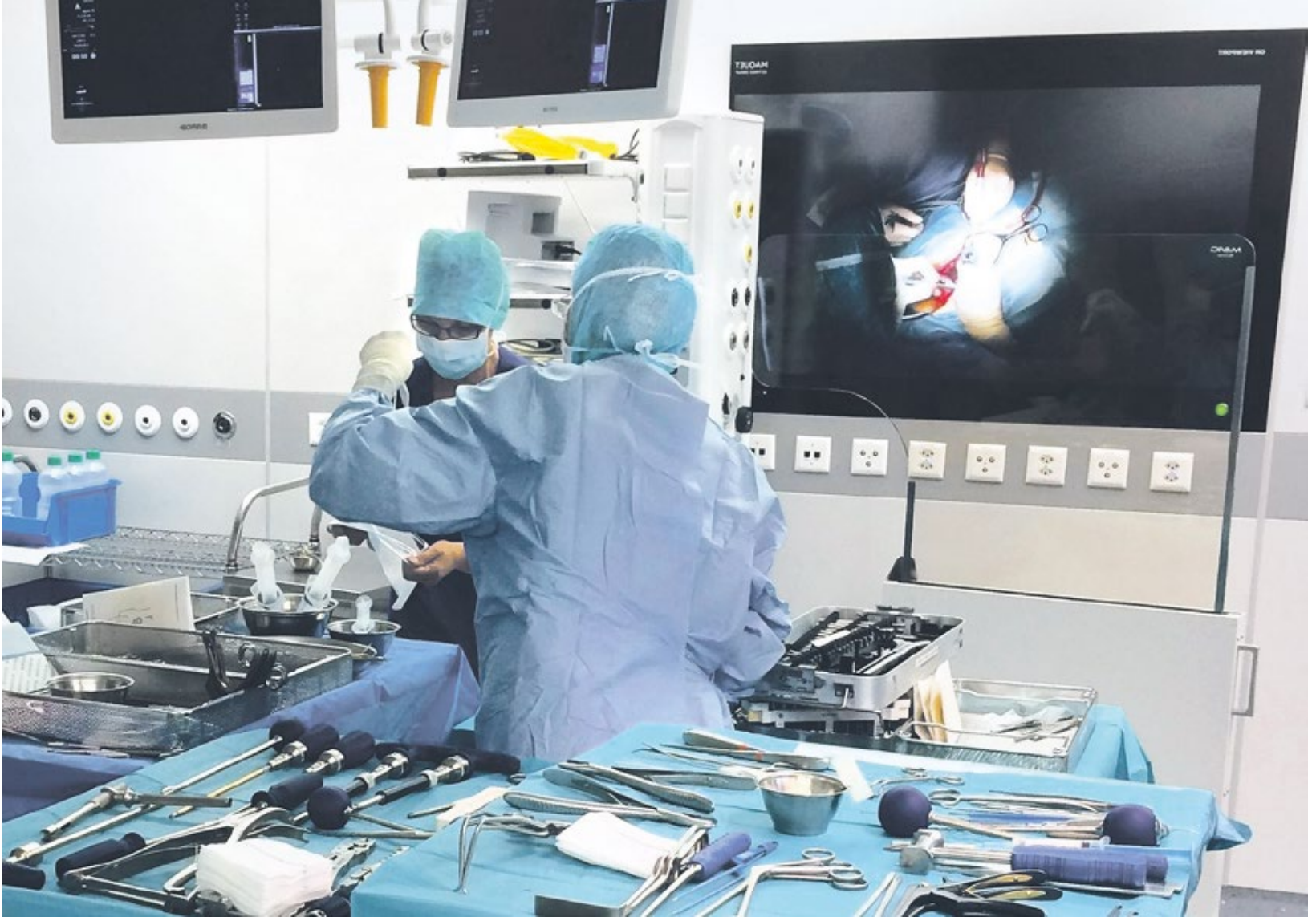
Infektionsprävention im OP lässt sich durch bauliche Maßnahmen unterstützen.
