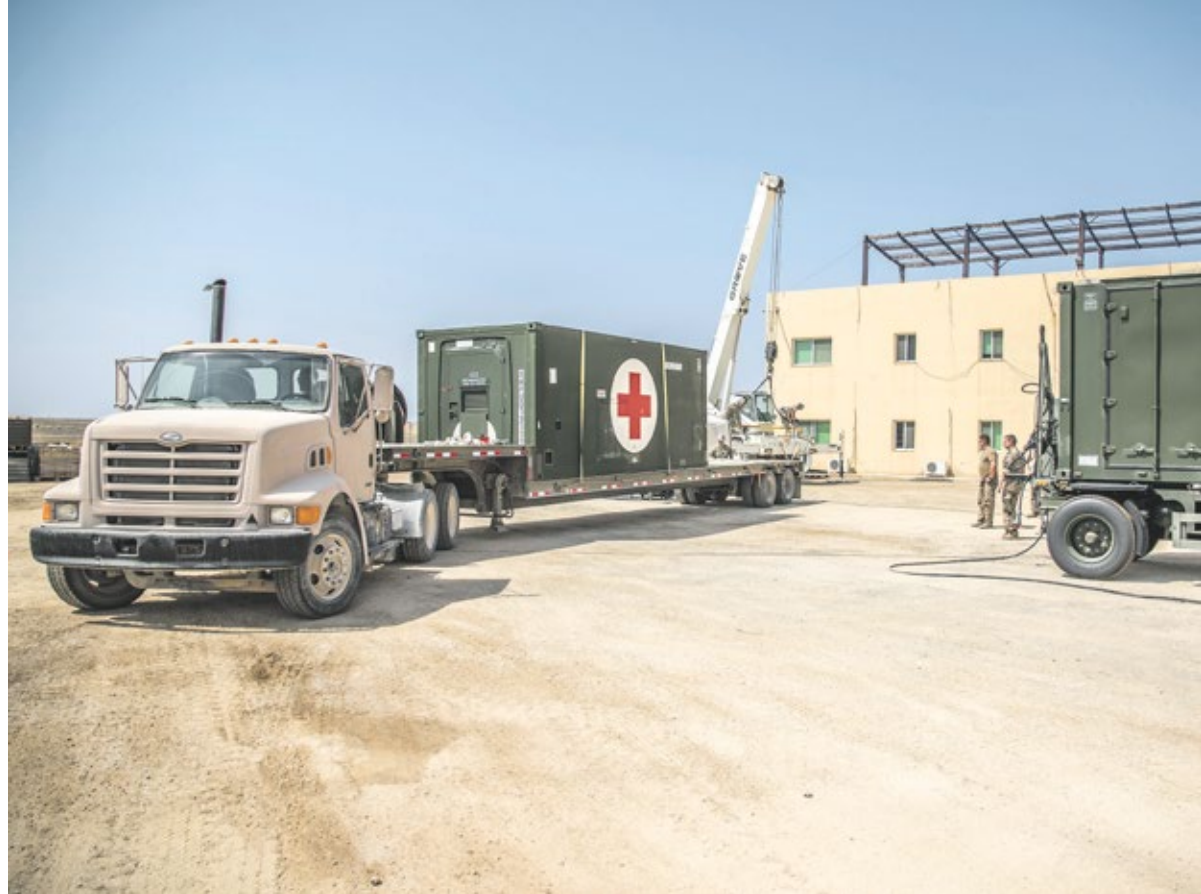
Aufbau einer Sanitätseinrichtung einschließlich autarker Versorgung in der jordanischen Wüste auf der Luftwaffenbasis Al-Azraq
