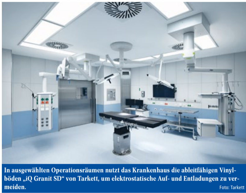
In ausgewählten Operationsräumen nutzt das Krankenhaus die ableitfähigen Vinylböden „iQ Granit SD“ von Tarkett, um elektrostatische Auf- und Entladungen zu vermeiden. Foto: Tarkett
