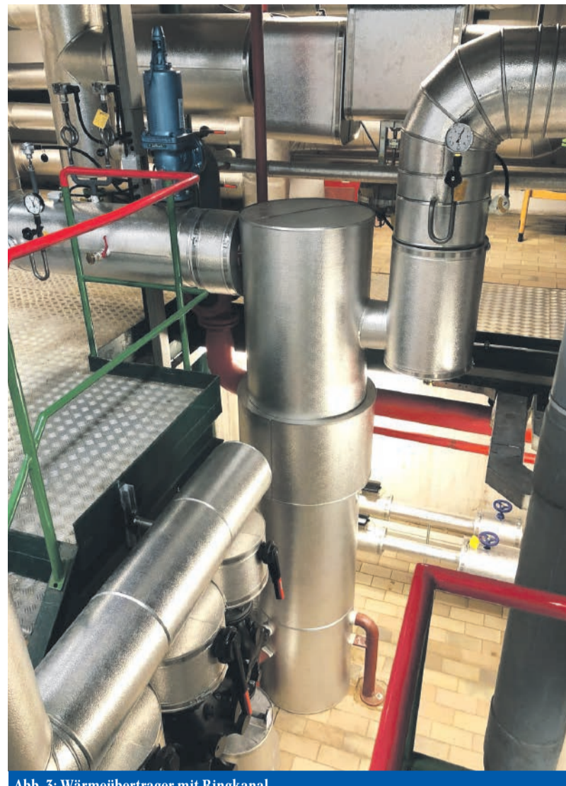
Abb. 3: Wärmeübertrager mit Ringkanal
