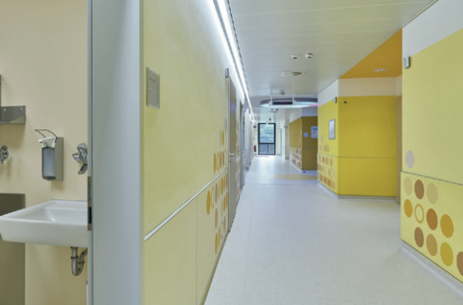
Die mit 2K-Aqua Seidenmattlack 2388 von Brillux beschichteten Türzargen sind beständig gegen Desinfektionsmittel, Handschweiß, Cremes und Fett.
