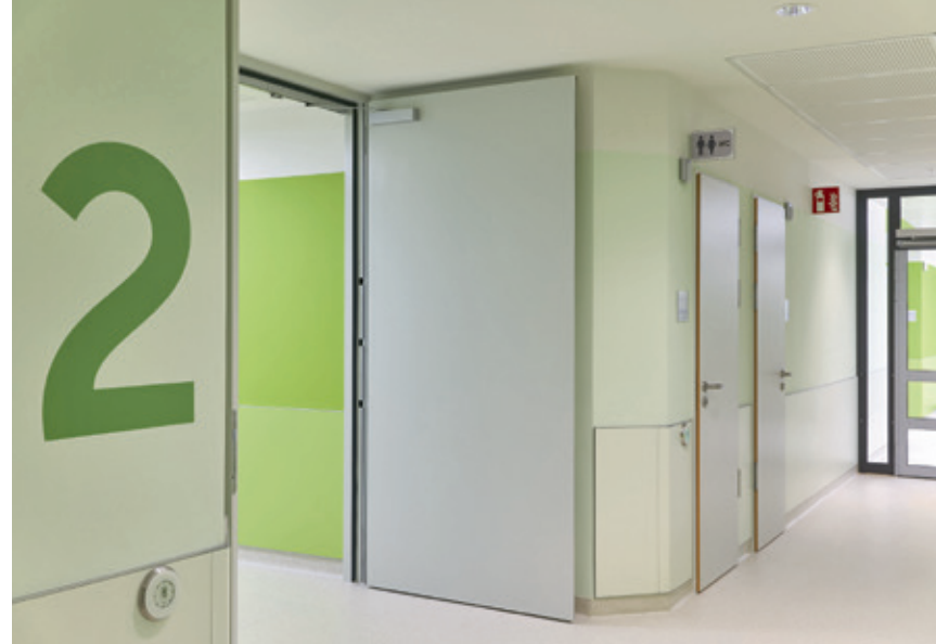
Die pulvergrundierten Feuerschutztüren wurden zunächst grundiert und dann zwei Mal mit 2K-Aqua Seidenmattlack 2388 im Farbton RAL 9002 Grauweiß beschichtet.
