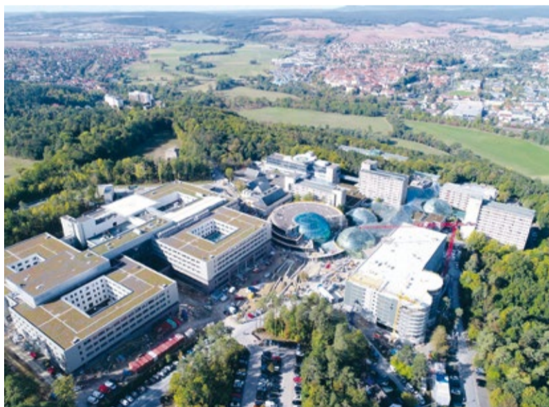
Der neue Rhön-Klinikum Campus Bad Neustadt verändert sich. Neubauten des Zentrums für klinische Medizin/ZkM (links) und Kuppel des Zentrums für ambulante Medizin/ZaM (Mitte) prägen den neuen Klinikstandort. Foto: Rhön Klinikum
