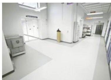
Nachher: sanierter, attraktiver Boden
