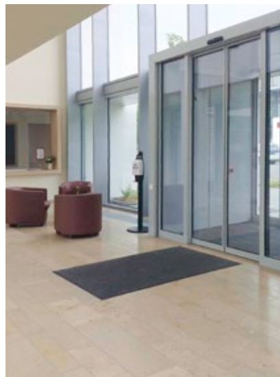
Spiegelnde und reflektierende Oberflächen werden als Wasser und Fußmatten im Eingang als Loch wahrgenommen und erhöhen die Unsicherheit und damit das Sturzrisiko. Bild: BifadA
