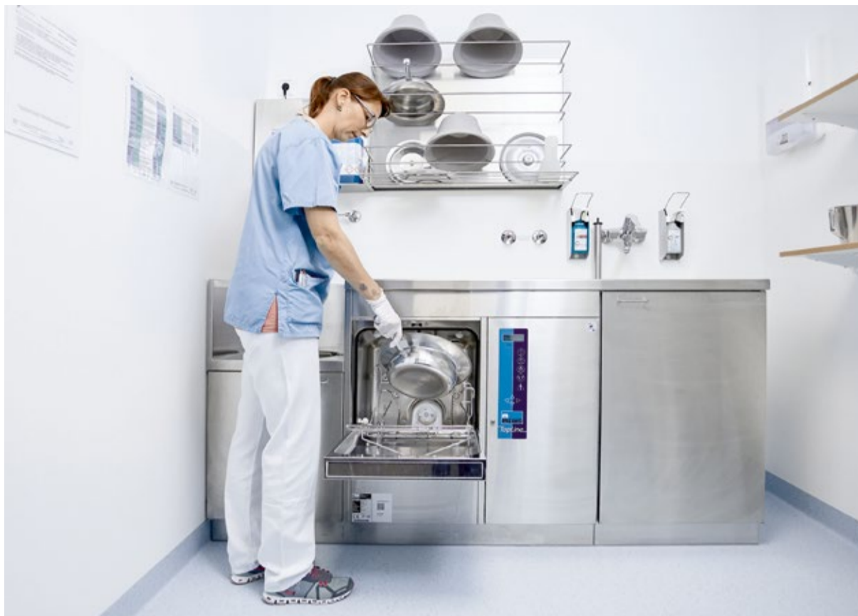
Krankenschwester Melanie Mahr arbeitet auf der Chest Pain Unit am Klinikum Fulda und weiß es zu schätzen, dass es nicht nur Steckbeckenspülgeräte in den Pflegearbeitsräumen gibt, sondern dass auch noch 40 % der Patientenzimmer mit Reinigungs- und Desinfektionsgeräten von Meiko ausgestattet sind.
