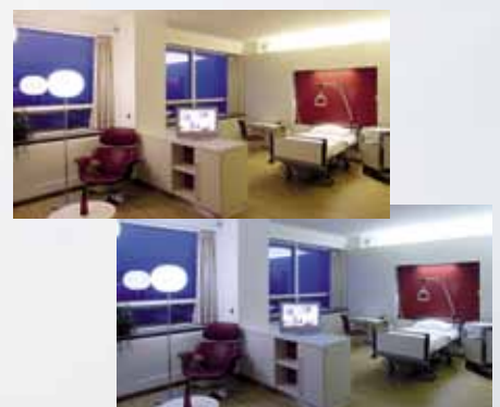
Die Farb-Szenen und Farbtemperaturen sind individuell einstellbar, tageszeitabhängige Sequenzen möglich und zusätzlich Bereiche unterschiedlich ansteuerbar.
