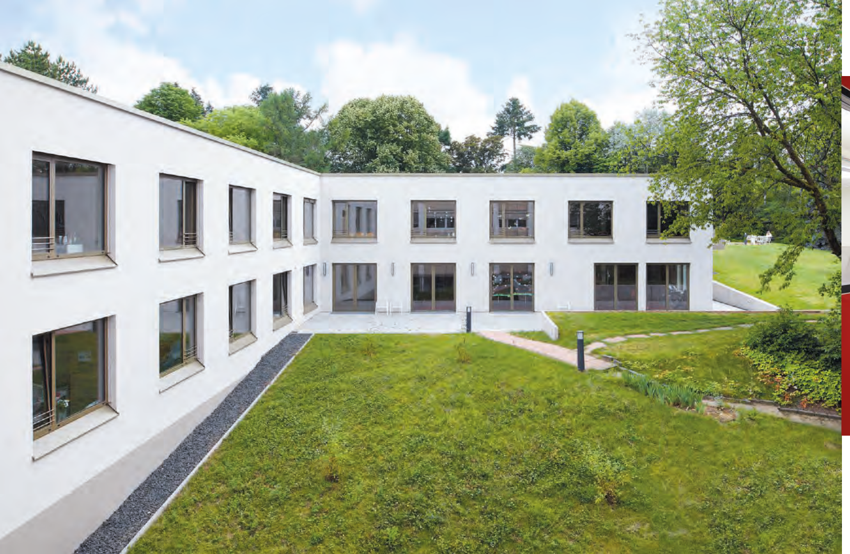
Die neue Geriatrie des Ketteler-Krankenhauses in Offenbach
