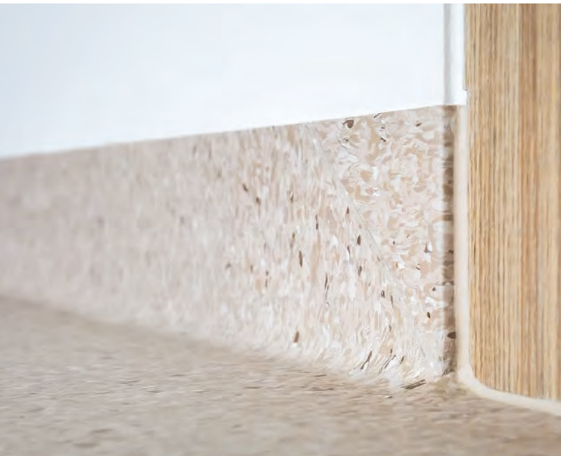
▲ Homogene Vinylböden der iQ-Familie lassen sich wannenförmig verlegen, um ungünstige Winkel und Ecken zu vermeiden, die schwer keimfrei zu machen und zu desinfizieren sind.
