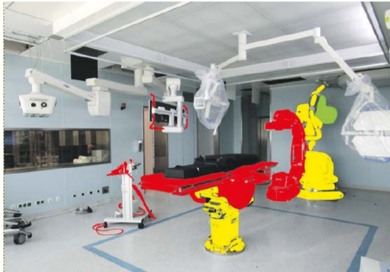
Visualisierung von hygienisch relevanten Oberflächen mittels einer Heat-Map. Dadurch sollen hygienisch relevante Oberflächen besser identifiziert werden können.
