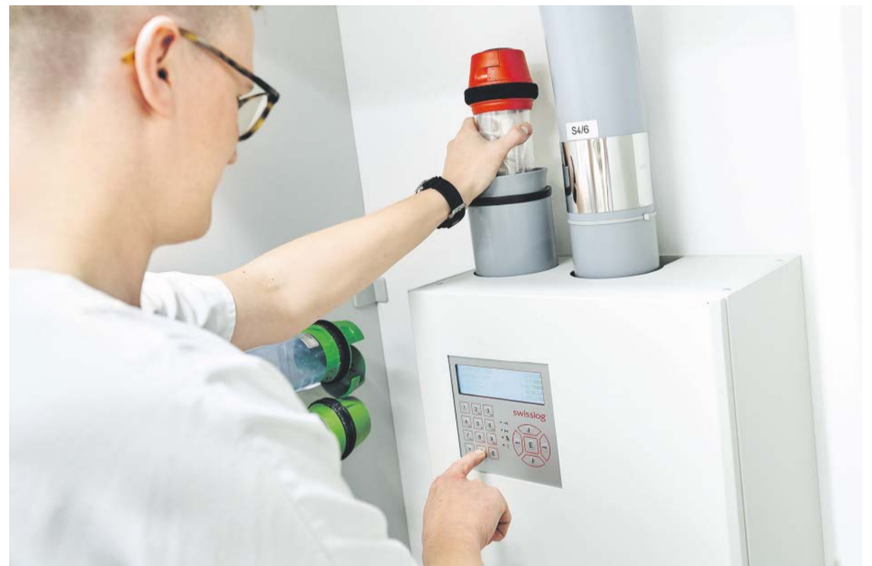
Eine Pflegekraft schiebt eine Probe mithilfe der Rohrpost ins Labor.
