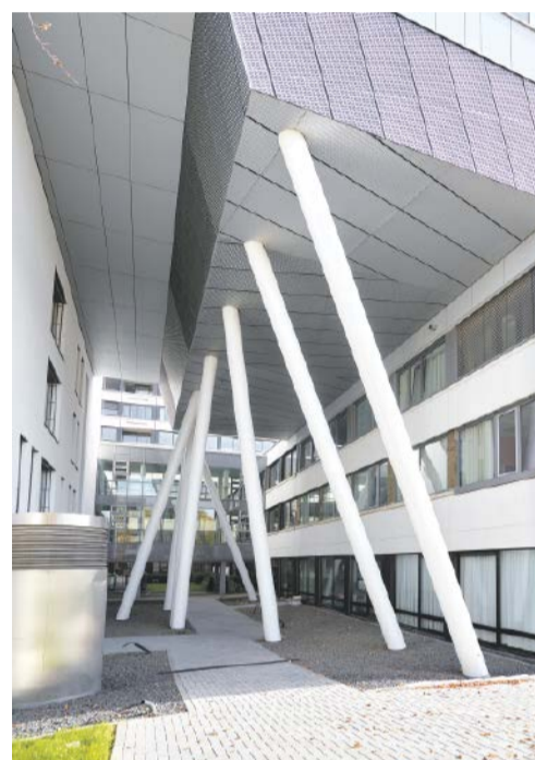
Der Optik des Modulbaus durch moderne Bauelemente sind wenig Grenzen gesetzt. Foto: ALHO, Fotograf: Martin Lässig
