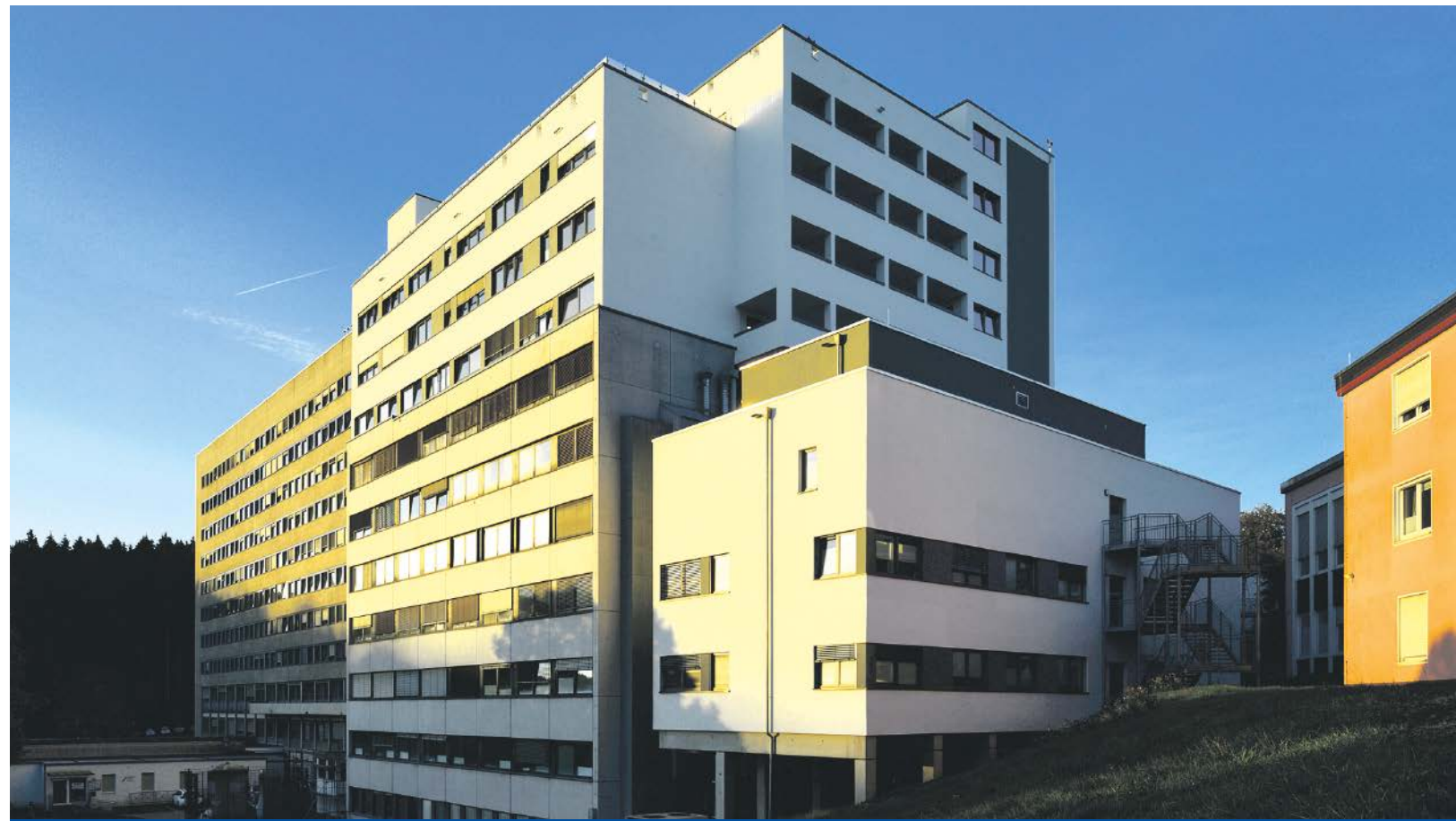
Ein Modulbauprojekt der Superlative realisierte das Diakonie-Klinikum Jung-Stilling in Siegen: Hier wurde ein Hybrid-OP an den Bestand angebaut und das Klinikgebäude um fünf Modulbaugeschosse im laufenden Betrieb erweitert. Die Aufstockung ist ein gelungenes Beispiel für Ressourcenschonung – besonders in Bezug auf die Flächeninanspruchnahme.
