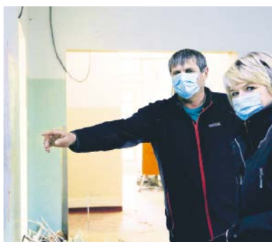
Noch sind die ehemaligen Lüftungsanlagen zu sehen, doch auch sie kommen raus, wie sich Verwaltungsdirektorin Marita Schönemann im Baugespräch mit dem technischen Bereichsleiter Reinhard Altwasser informierte.
