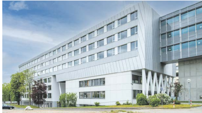
Mit 95 Metern Gebäudelänge und 20 Metern Gebäudetiefe bietet das um insgesamt 69 Alho-Module aufgestockte Marienhaus Klinikum Mainz (mkm) einen imposanten Anblick. Das Bestandsgebäude 204 des ersten Bauabschnitts wurde konstruktiv für eine solche Aufstockung mit einem 50 cm hohen Stahlträgerrost aufgerüstet. Über ihn werden die Lasten des Modulbaus in die Bestandsstützen eingeleitet.
