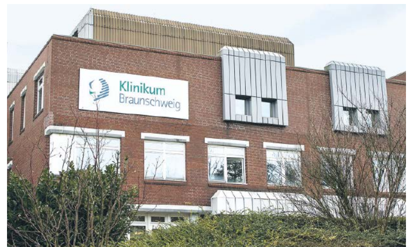
Der Demonstrator soll auf einer Freifläche des Klinikums am Standort Naumburgstraße unweit des Standorts Salzdahlumer Straße aufgestellt werden.
