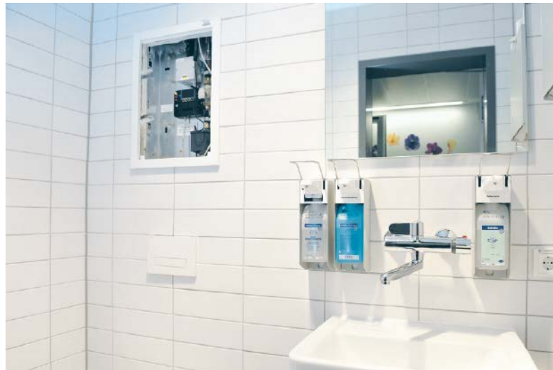
Die automatisch auslösenden Spülstationen von Viega erkennen sowohl die Dauer von Nutzungsunterbrechungen als auch eventuelle thermische Auffälligkeiten – und sorgen dann selbsttätig für den hinreichenden hygienisch notwendigen Wasseraustausch.
