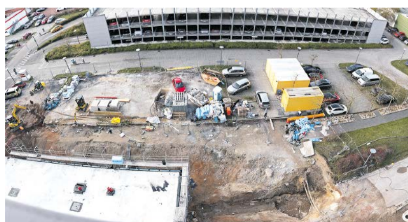
Auf der Fläche, auf der jetzt noch Baufahrzeuge und -container stehen, wird das Haus 20 entstehen.
