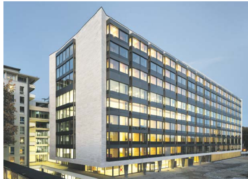
Das neue Bettenhochhaus grenzt an das bestehende Bettenhaus (links) an.
