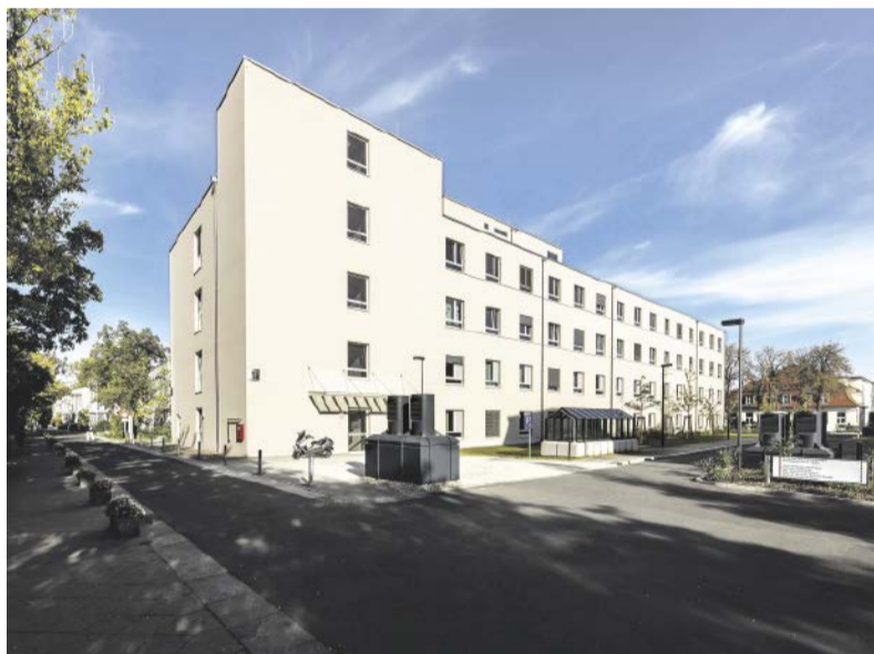
Mitten im Corona-Jahr 2020: So konnte auf dem Klinikgelände in Berlin Neukölln der Neubau einer viergeschossigen Bettenstation in Alho-Modulbauweise eröffnet werden – nach nur 24 Wochen Bauzeit vor Ort. Foto: Alho Unternehmensgruppe
