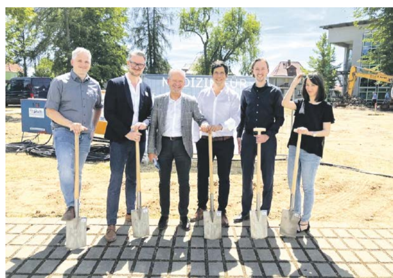
V.l.n.r.: Ronny Großer (C&E Consulting und Engineering GmbH), David Ksoll (technischer Leiter Krankenhaus Mittweida), Tino Fritzsche (C&E Consulting und Engineering GmbH), Patrick Hedwig, Sven Bremer und Ioulia Chatzidakis (alle Sweco)
