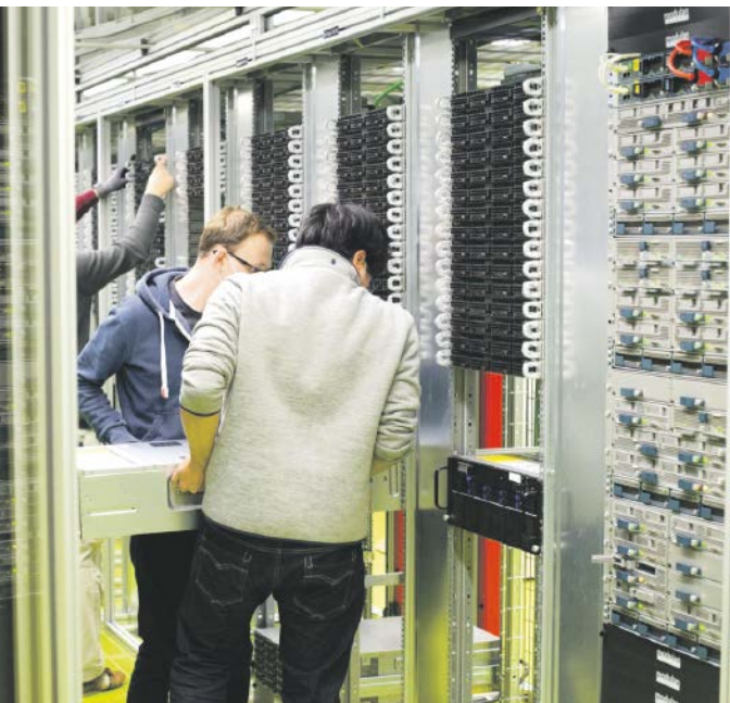
Upgrade des Uni Essen Datacenters mit NVIDIA Technologie
