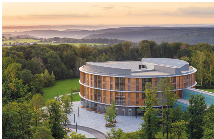
Neubau Waldkliniken Eisenberg, Neubau Bettenhaus in Holzhybridbauweise
