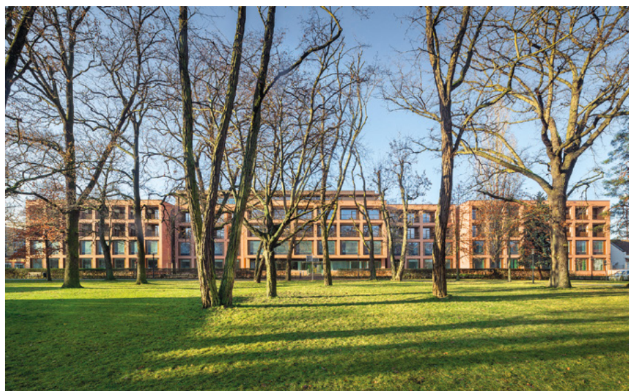
Rehabilitations-Klinik UKB Reha – Unfallkrankenhaus Berlin
