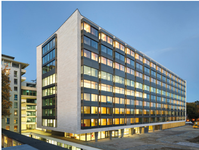
Ersatzneubau Kantonsspital Winterthur
