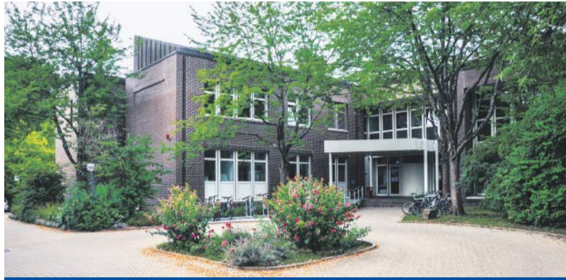
Sauter nahm eine energetische Modernisierung am zell- und molekularbiologischen Labor (ZMF) in Tübingen vor, das momentan als Forschungslabor der Radiologischen Universitätsklinik Tübingen genutzt wird. Foto: Sauter
