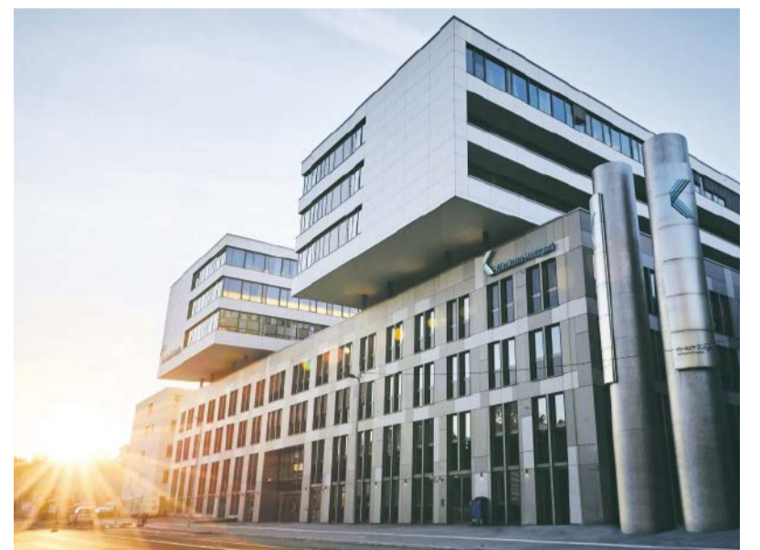
Prägnante Begrüßung: Das Gebäude mit dem zentralen Haupteingang wurde bereits in diesem Jahr eröffnet. Die gesamte Fertigstellung dürfte bis 2021 dauern. Foto: Klinikum Stuttgart
