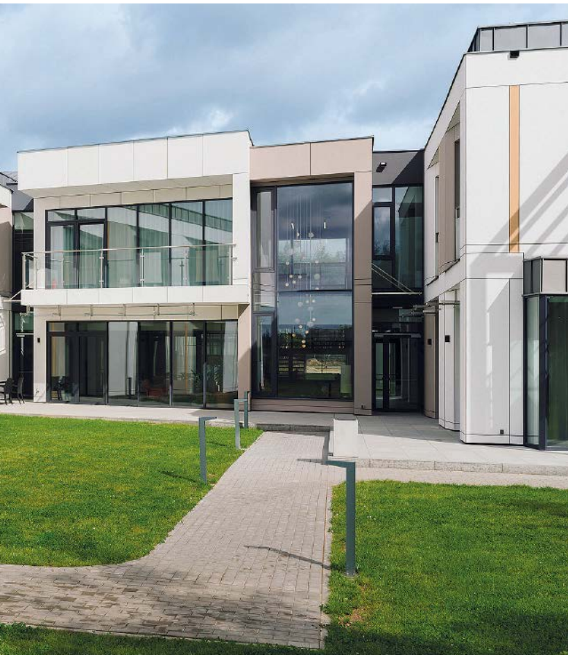
Das Architekturstudio Zawieja hat das Rehabilitationszentrum in Poznań (PL) zu einem besonderen Ort gestaltet. Auf den rund 3.500 Quadratmetern Wohn- und Nutzfläche finden sich zahlreiche Produkte von Hewi.
