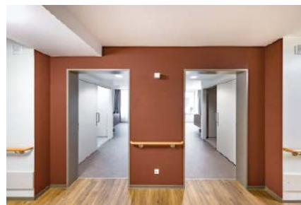
Um eine klare optische Differenzierung zu schaffen, wurden auf den öffentlichen Flächen – hier der Flur – Vinyl-Planken und in den privaten Zimmern Bahnenware verlegt.
