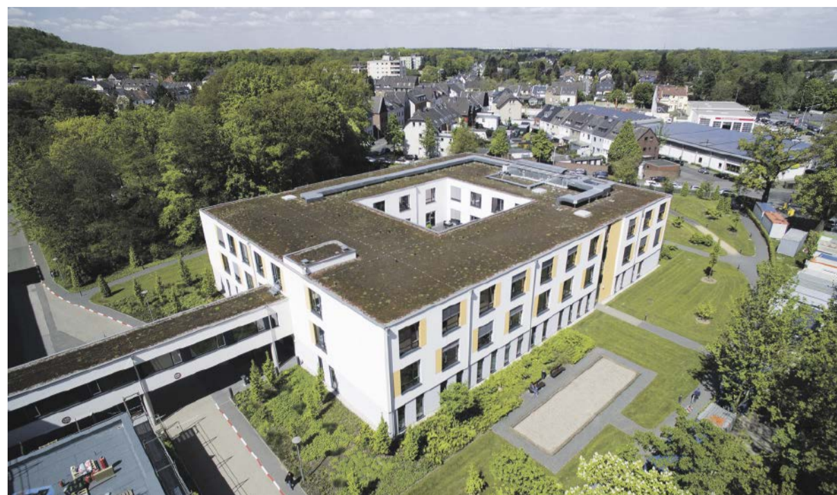
Ein Gründach entsiegelt Flächen bzw. dient als Ausgleich für versiegelte Flächen. Es schafft Biodiversität, Lebensraum für Insekten und Nahrungsquellen für Vögel. Neben CO 2 speichert es Feuchtigkeit und trägt zu angenehmem Raumklima bei. Foto: Alho Systembau GmbH
