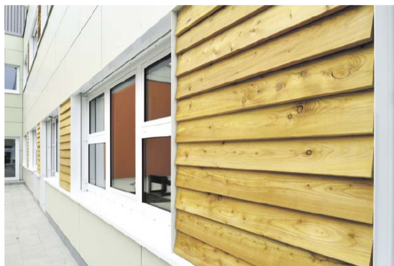
Der Einsatz unterschiedlicher Materialien ermöglicht individuelle Fassadengestaltung. Der ökologische Gedanke kann durch den Einsatz von Holzpaneelen betont werden. Foto: Alho Systembau GmbH
